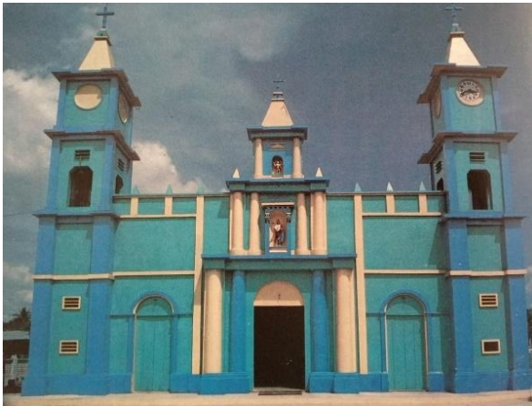
Jalupa , Fachada de la iglesia de San Juan Bautista antes de su reconstrucción. (Foto, Campos 1988:114)
